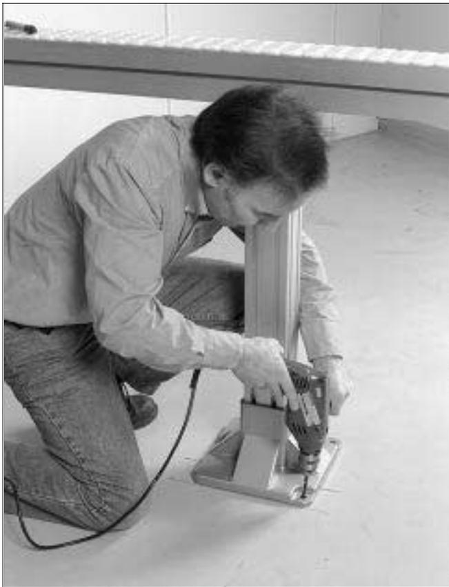
4 Im Fußboden Bohrungen zur Befestigung des Fußes bohren.
