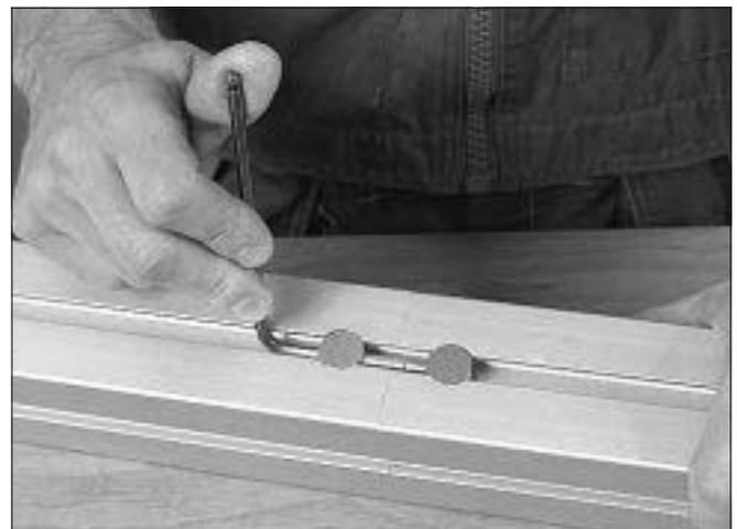
4 Verbinden Sie die Bügel auf der anderen Profilseite. Ziehen Sie die beiden Schrauben fest.
