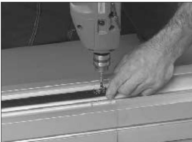
3 Bohrungen für die Kunststoffschrauben XWAG 5 bohren.
