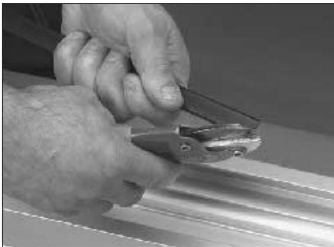
1 Gleitschiene im Winkel von 45° schneiden.
