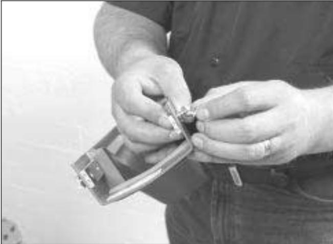
1a Zwei Vierkantmuttern an der Tropfwanne befestigen. Falls Haltewinkel erforderlich sind (für XH und XK 90° senkrechte Bogen), sind sie an den senkrechten Bogen zu befestigen. Schrauben nicht ganz festziehen.
