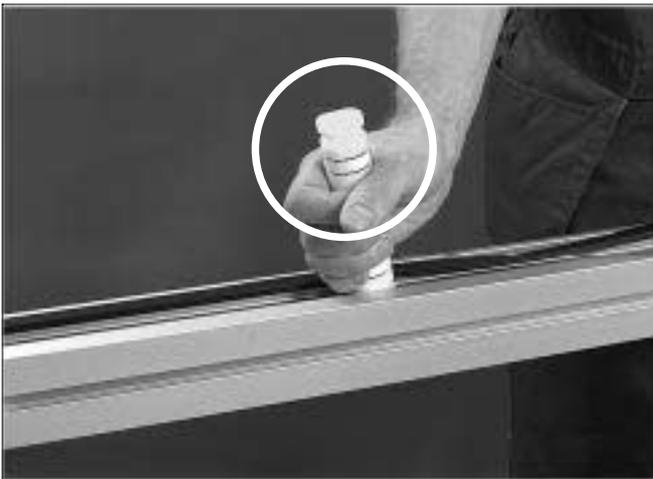
3 Verwenden Sie das Gleitschienenmontagewerkzeug, um die Schiene einzupressen. Eine Seite des Werkzeuges ist für die Montage auf der ersten Seite, die andere Werkzeugseite für die Montage auf der zweiten Seite des Profils vorgesehen.
