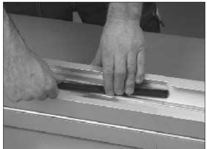
2 Gleitschiene am unteren Flansch des Führungsprofils befestigen.
