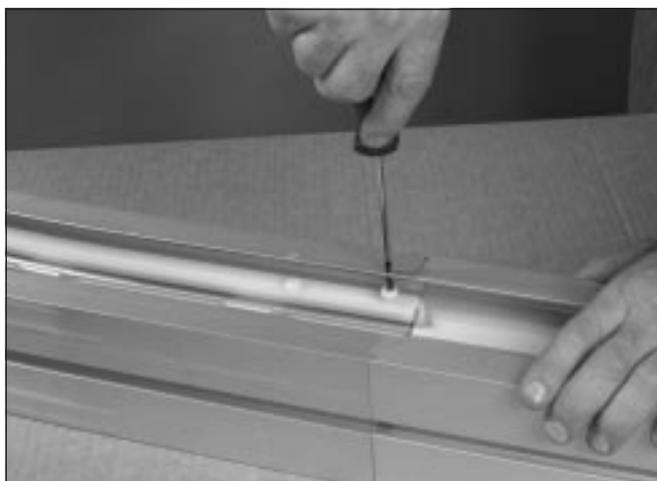
3 Retire la sección de raíl de deslizamiento superior. Fije el raíl de deslizamiento inferior al perfil con tornillos de plástico XWAG 5. Corte todas las cabezas de los tornillos. Lime los salientes. El corte debe realizarse en dirección opuesta a la posición de la unión, siguiendo la dirección de desplazamiento.
