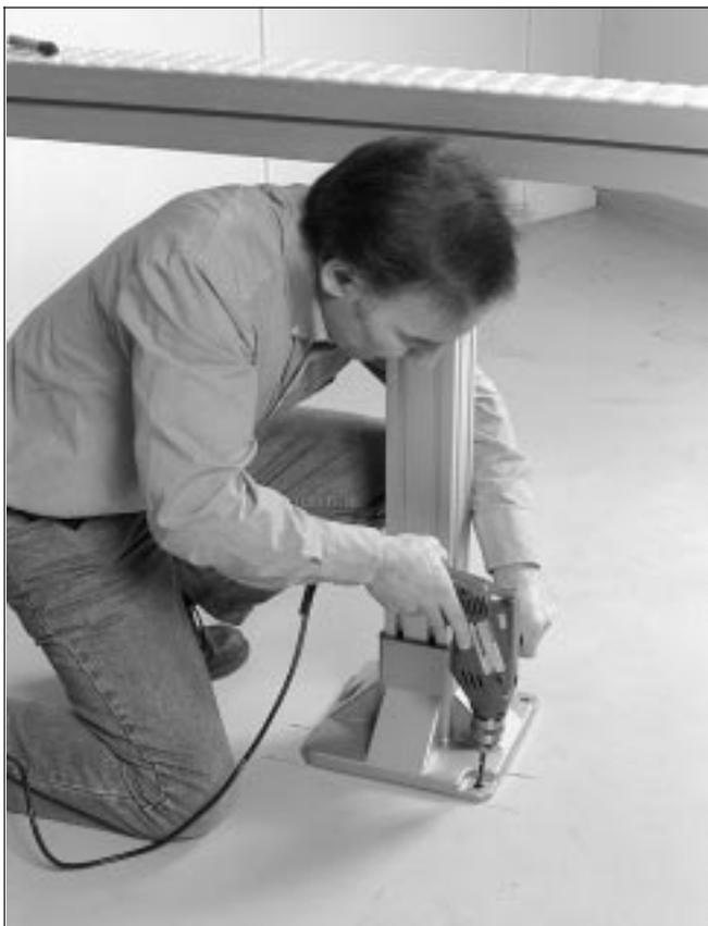
4 Taladre orificios en el suelo para el acoplamiento del pie.
