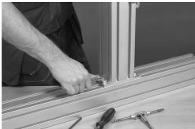
4 Atornille la platina de montaje en el lateral del perfil transversal utilizando tornillos allen M6S 8x16.
