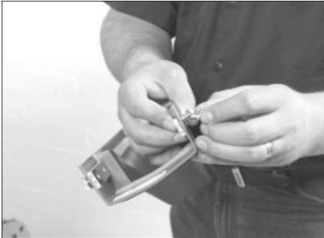
1 Conecte las tuercas cuadradas a un extremo de la cubeta de goteo y no las apriete totalmente. Utilice un par con X\_DC, X\_DD y X\_DE, y dos pares con X\_DJ y X\_DH. Deslice la cubeta de goteo sobre un tramo de bandeja de goteo.
