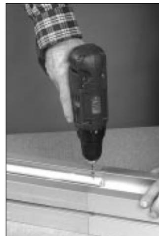
2 Monte una sección corta de raíl de deslizamiento en la pestaña superior. Use el útil de taladrado para practicar orificios en el raíl de deslizamiento, en las pestañas superior e inferior. Utilice una broca que tenga la longitud suficiente para taladrar ambas pestañas.
