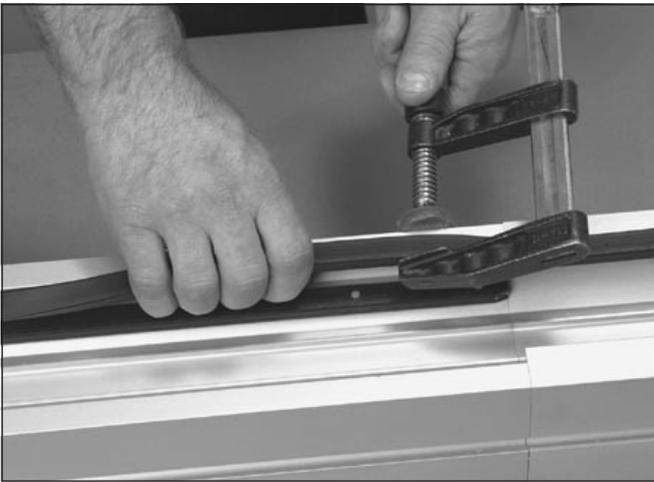
7 Utilice una mordaza para sujetar el raíl de deslizamiento en la pestaña del perfil, en el punto donde comienza el perfil tipo N.
