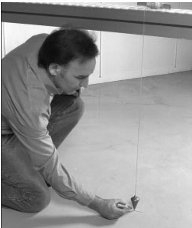
1 Tire la plomada en ambos extremos del perfil del transportador y marque la anchura del perfil en el suelo.
