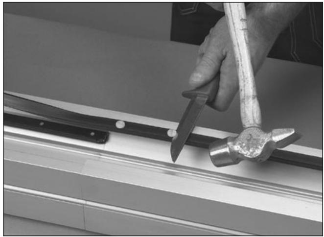
6 Utilice un destornillador para introducir los tornillos. Corte las cabezas de los tornillos con una cuchilla y un martillo. Lime los salientes. El corte debe realizarse en dirección opuesta a la posición de la unión, siguiendo la dirección de desplazamiento.
