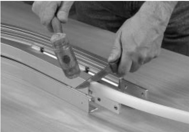
3 Corte el raíl en el otro extremo a un ángulo de 90° utilizando una cuchilla y un martillo de plástico.
