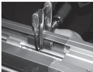
7 Befestigen Sie die Schiene mit ISO 7049 4,2x9,5-Blebschrauben See „Stützschiene für Gleitbögen XH“ Siehe Seite 226. (niemals längere Schrauben als 9,5 mm benutzen).
