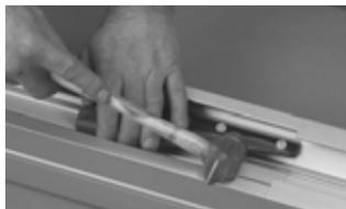
5 En la brida superior del raíl de deslizamiento, utilice el útil de taladrado para perforar dos orificios en el raíl de deslizamiento antes de que entre en el perfil XKCB N.
