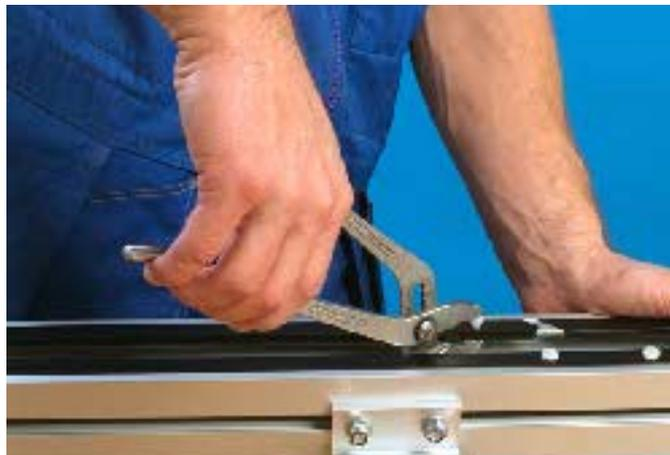
1 樹脂ネジをネジ回しでねじ込むか、プライヤーを使って圧入します。
