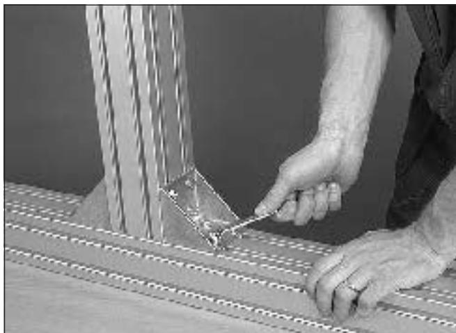
3 Instale o suporte angular na viga transversal do mesmo modo. Aperte os parafusos todos.
