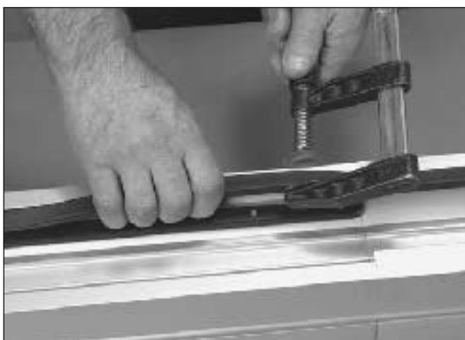
7 Use um grampo para pressionar o trilho de deslizamento sobre o flange da viga, no local em que tem início a viga tipo N.
