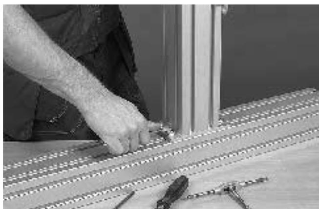
4 Parafuse a placa de montagem ao lado da viga transversal com parafusos sextavados M6S 8x16.
