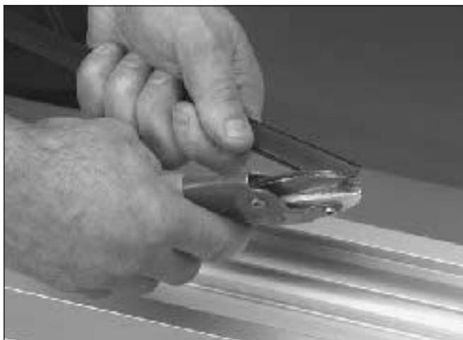
1 Corte o trilho de deslizamento a 45°.
