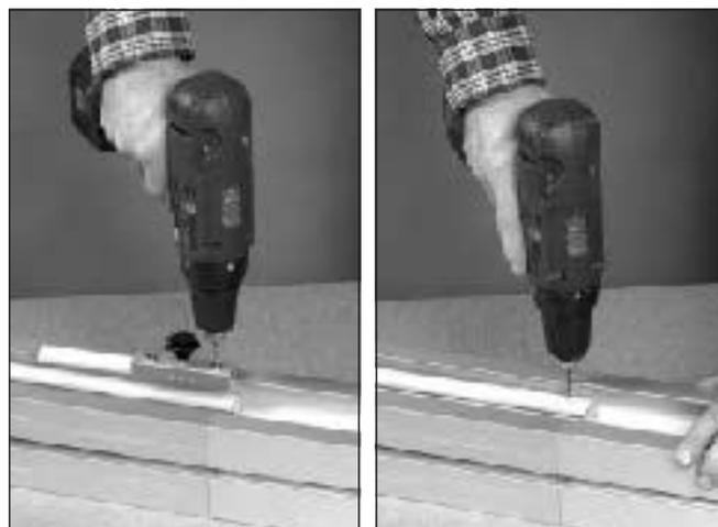
2 Instale um pedaço pequeno do trilho de deslizamento no flange superior. Use a ferramenta para furar para abrir furos no trilho de deslizamento, nos flanges superior e inferior. Use uma broca com comprimento suficiente para furar ambos flanges.
