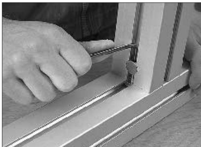
4 Aperte os parafusos com uma chave Allen. (Aperto recomendado para uma união lubrificada: 10 Nm.)
