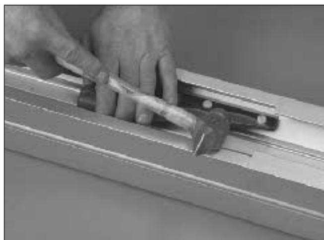
4 Use uma chave de fenda para introduzir os parafusos. Corte as cabeças dos parafusos com uma faca e um martelo. Remova saliências com uma lima.
