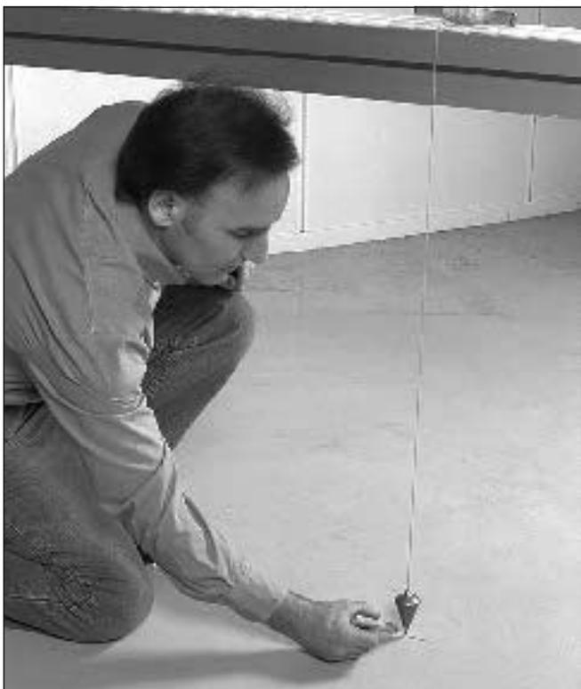
1 Sonde com o prumo de ambos lados e marque a largura da viga no piso.
