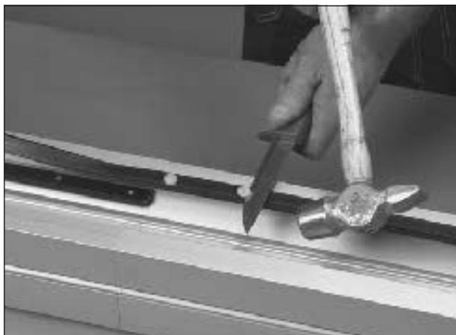
6 Use uma chave de fenda para introduzir os parafusos. Corte as cabeças dos parafusos com uma faca e um martelo. Remova saliências com uma lima. O corte deve ser feito longe da união, na direção do movimento.
