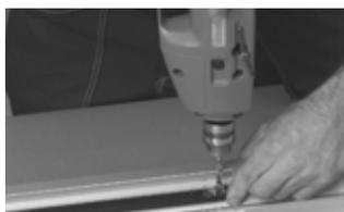
4 Utiliser un tournevis pour insérer les vis. Couper les têtes de vis à l'aide d'un couteau et d'un marteau. Limer les bords qui dépassent.
